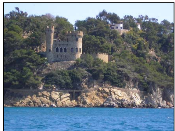
Vista de la façana litoral del sector del Castell de Lloret inclòs en el PDUSC (UTR-C 093).
