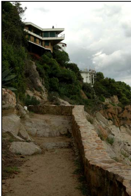
Propietats construïdes sobre el penya-segat a l'alçada en la zona de la Cala d'en Simón.
