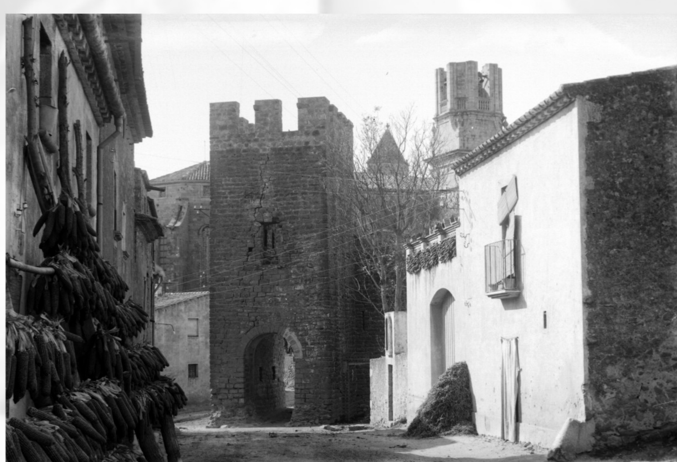
Torre medieval a Torroella de Montgrí
