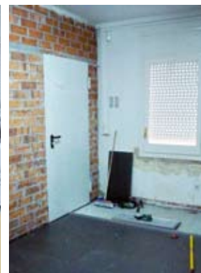
Fase d'obres a la sala de classificació.
