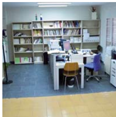
Fase d'obres a la sala de consulta.
