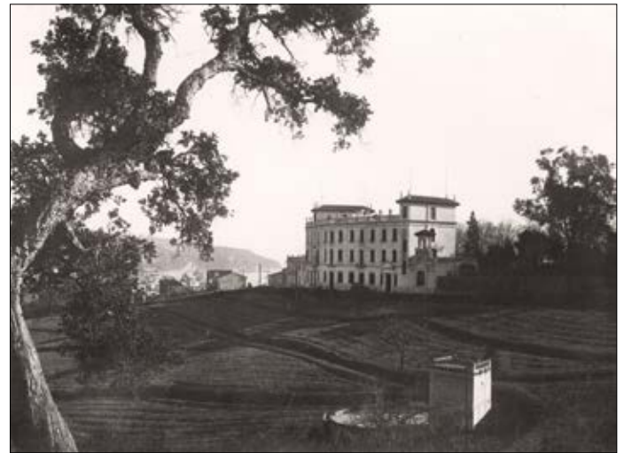
Vista general de la Torre Campderà. Data: ca. 1935.
