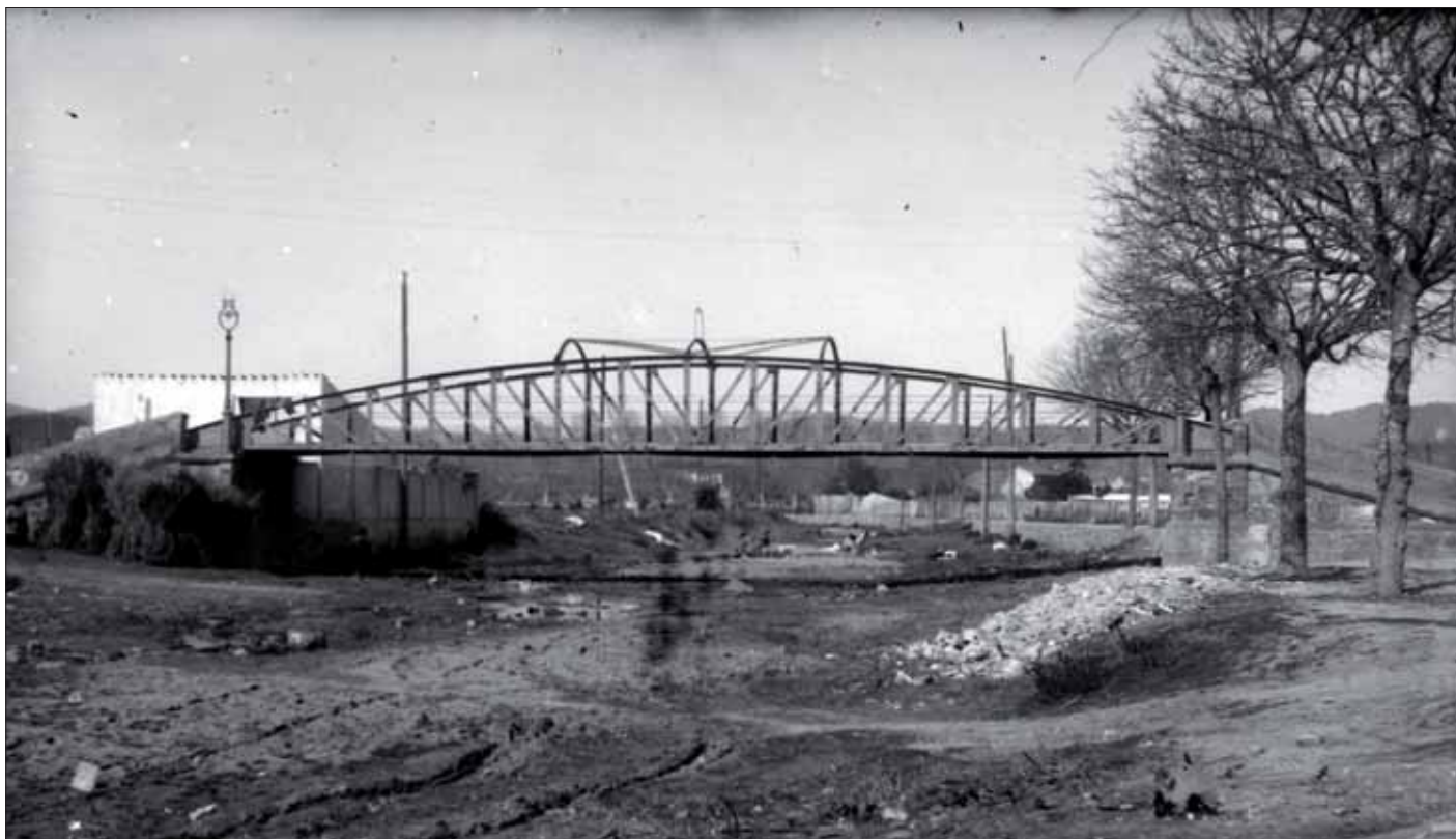
Perspectiva general del Pont de Ferro, on s'hi poden veure els esglaons d'obra on descansava l'estructura.
