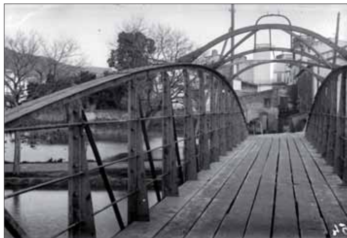
Vista de detall del Pont de Ferro.
