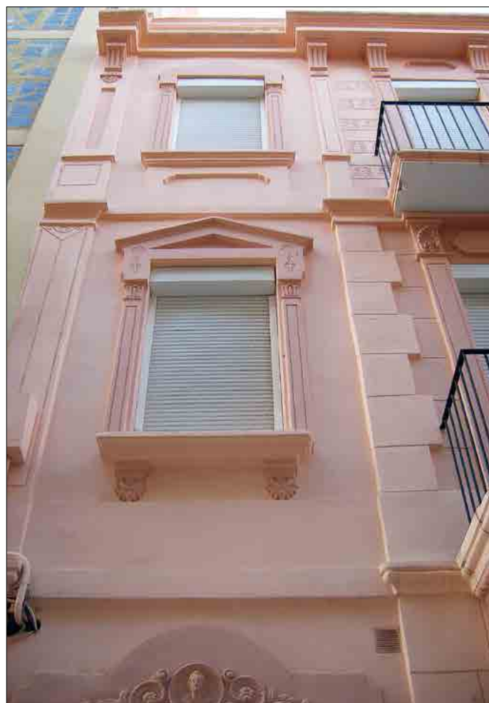
Detall de l’emmarcament de les finestres.
