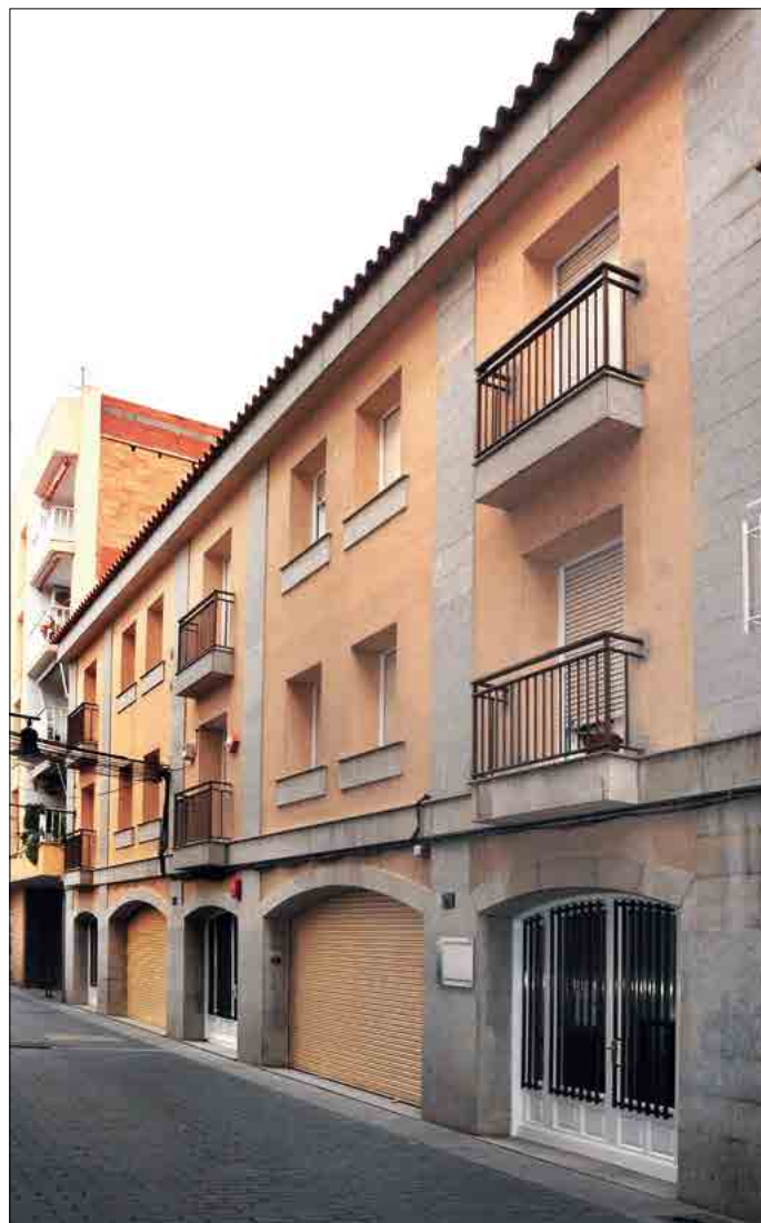
Façana de l'edifici central del SAMLM. Procedència: SAMLM (Assumpció Comas)
