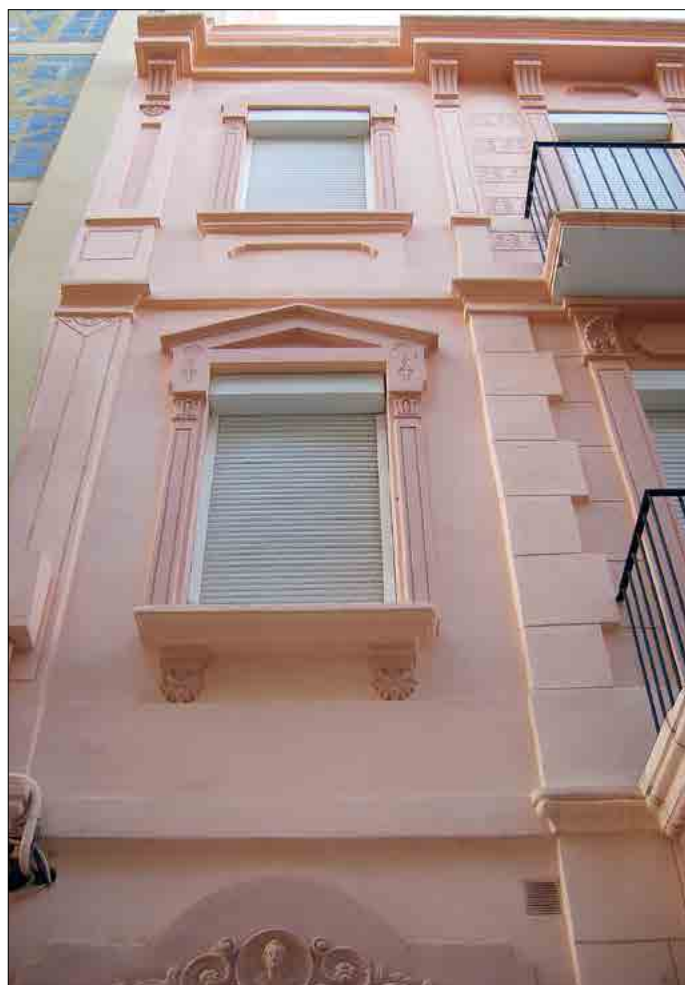
Detall de l’emmarcament de les finestres.
