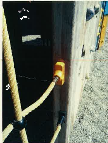
FOTOS 133 i 134: Col·locació del túnel de malla nou i d'un suport de la corda d'escalada del vaixell del parc infantil de la Sardana.
