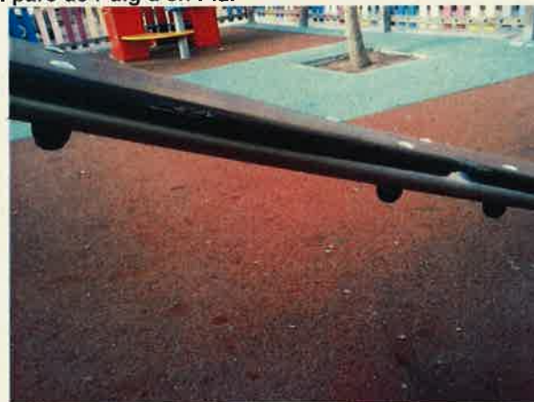
FOTOS 129 i 130: Cargols robats a la rampa d'accés a la torre del parc infantil dels Drets Humans i posterior col·locació de nous amb tap de protecció.
