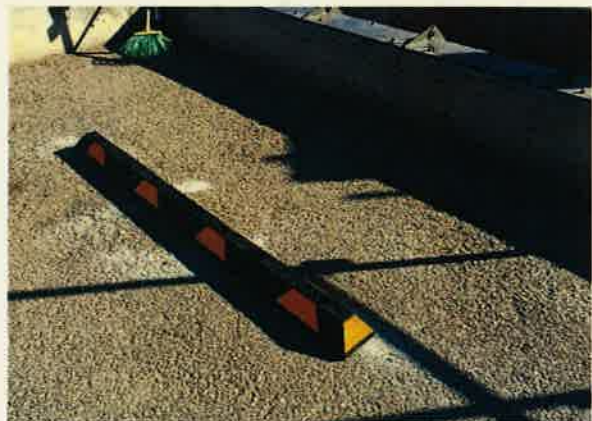
Foto 6: Topalls instal·lats en el moll de descàrrega.
