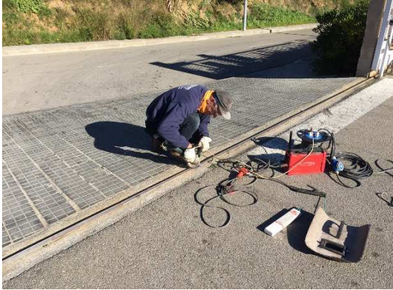
Foto 73: Reparació de les rodes de la porta d'accés principal a la instal·lació.
