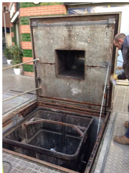
FOTOS 13 i 14: Reparació de les comportes dels contenidors soterrats del carrer Verge de Loreto.
