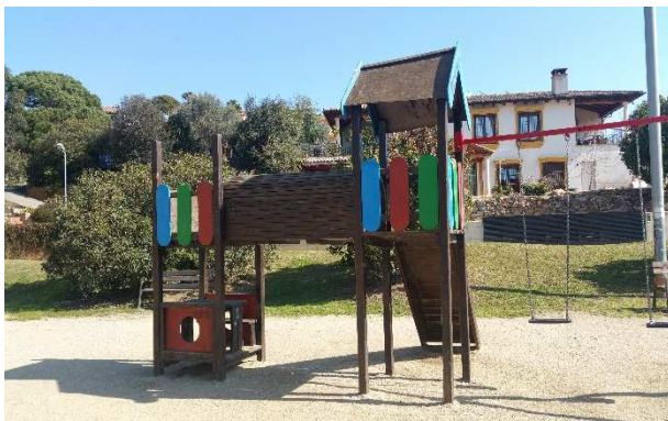
FOTOS 73 i 74: Estat del deteriorament de la fusta del joc principal del parc infantil de carretera de Tossa.
