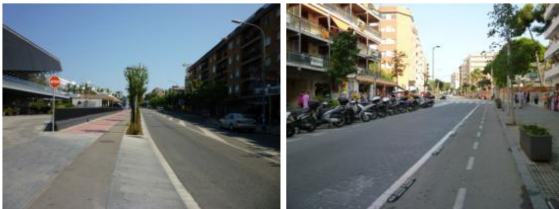
Imatge 13. 2 Carrils bicis urbans de Lloret de Mar. El de l'esquerra, segregat en vorera, correspon a l'Avinguda de Tossa i el de la dreta, segregat en plataforma única, correspon a l'Avinguda Amèrica.
