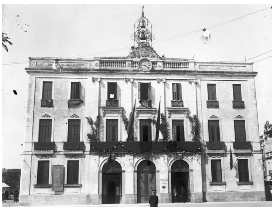
Casa consistorial de Lloret de Mar, on hi havia situada l'estació telegràfica. Procedència: SAMLM - Fons Ramon Rovira Fàbregas. Data: 1914. Autoria: Ramon Rovira Fàbregas. CID: 699.112.200_323.038.012.
